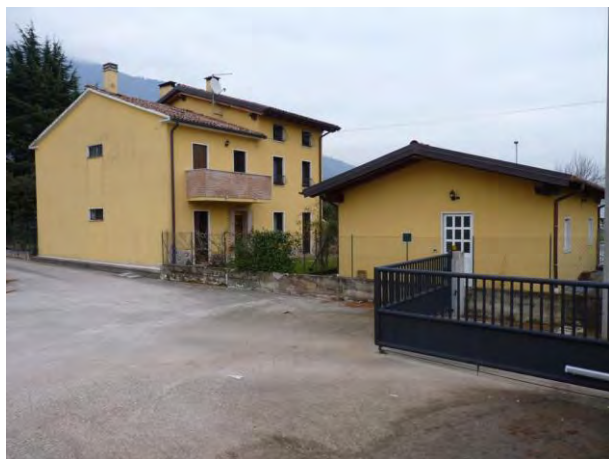
Cono di presa 9
