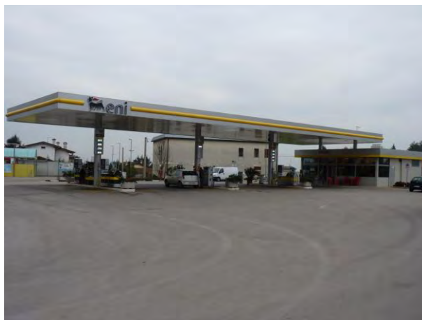
Cono di presa 10
