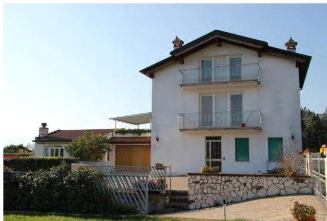
Cono di presa 2
