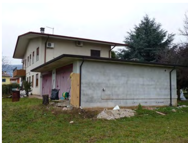
Cono di presa 6
